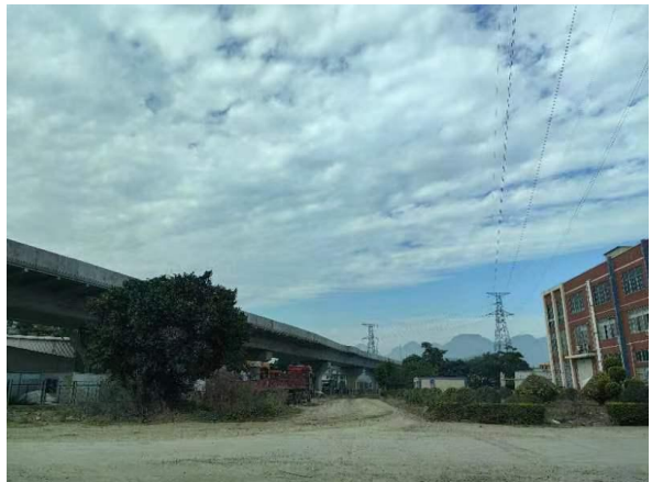
项目西南侧在建 F1 线
