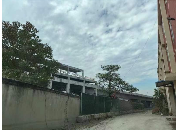
项目东南侧在建 F1 线
