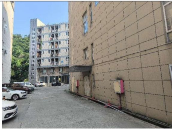
项目西侧厂房
