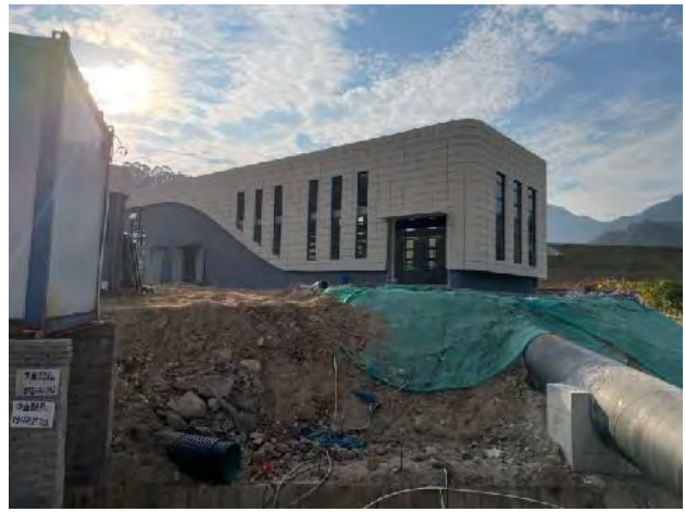
靠近排洪沟侧的临时下边坡无相关临时围挡， 容易造成冲刷至排洪渠内，影响排洪渠泄洪能力
