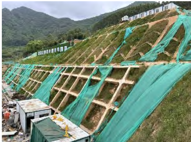
预应力锚杆框架护坡
