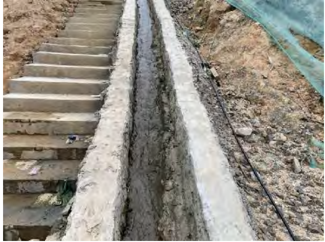
截水沟运行正常
