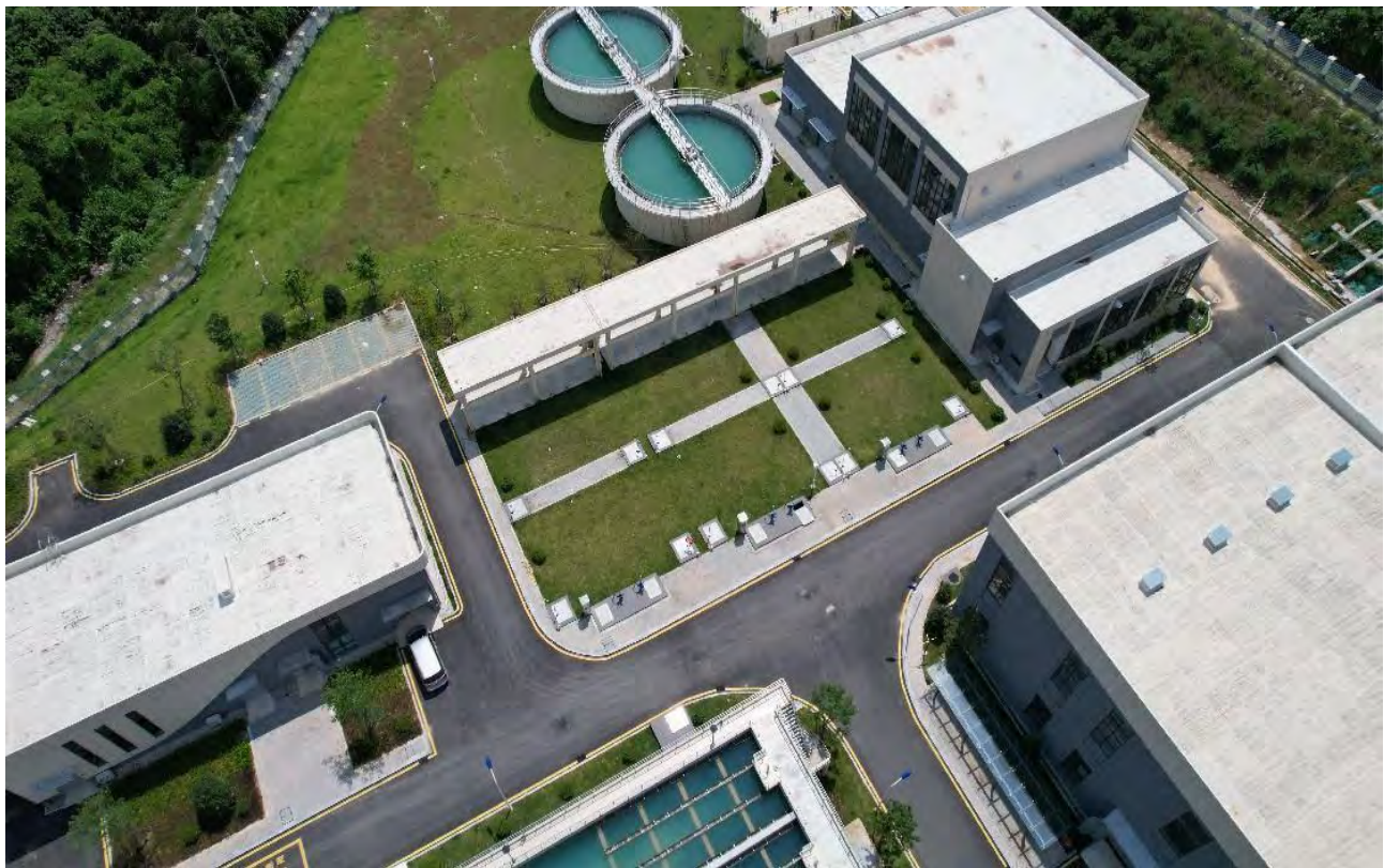
主体建筑及场内硬化道路
