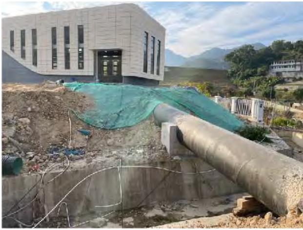
靠近排洪沟侧的临时下边坡无相关临时围挡， 容易造成冲刷至排洪渠内，影响排洪渠泄洪能力
