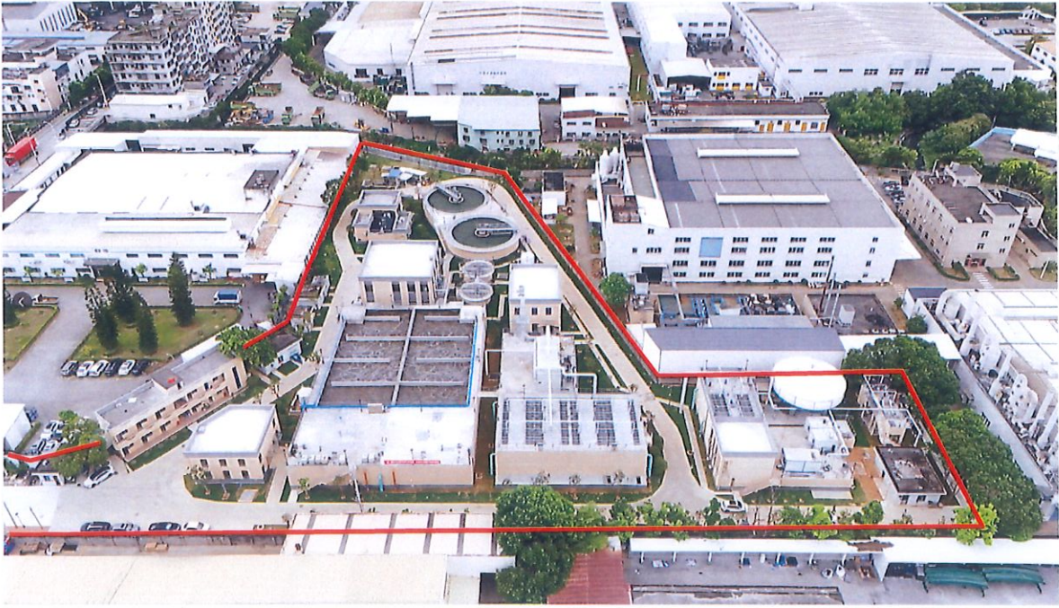
主体工程区航拍
