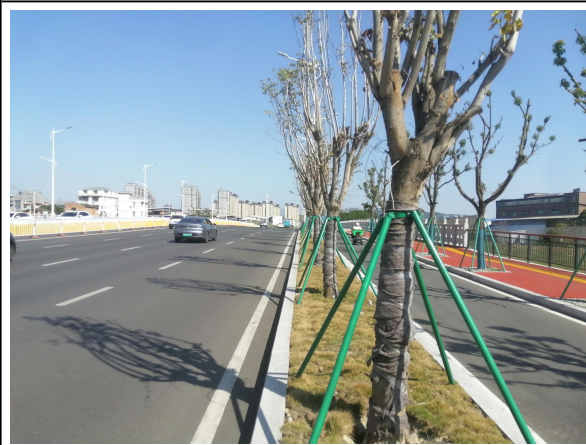
项目沿线现状照片
