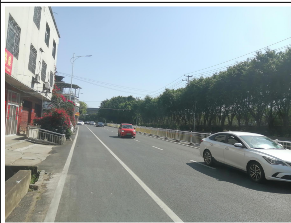
项目沿线现状照片
