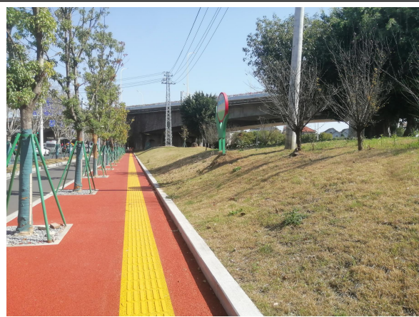
植草护坡现状照片
