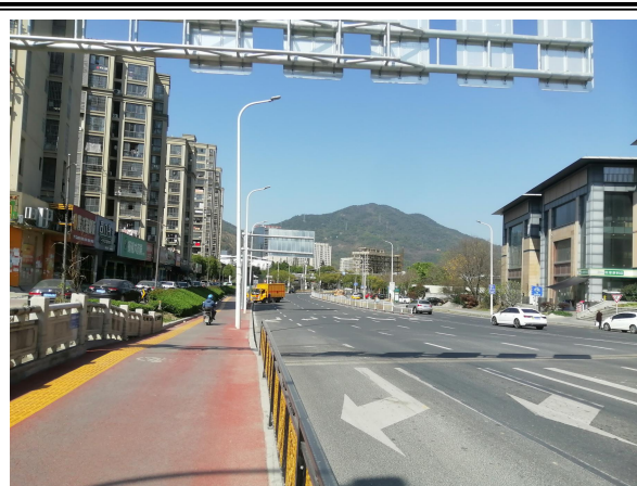
项目沿线现状照片
