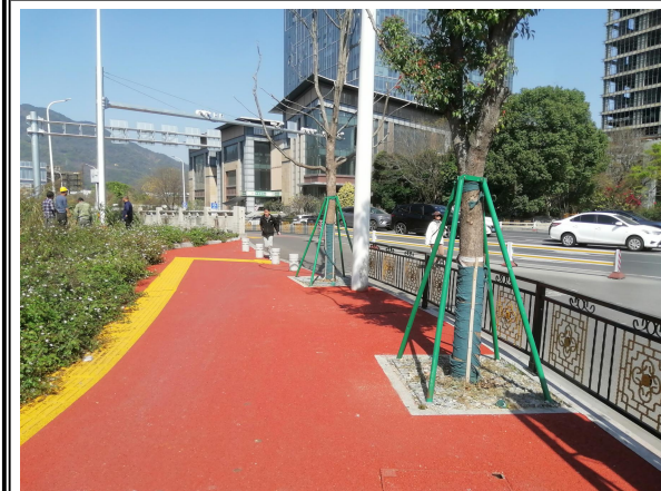
人行道彩色透水混凝土照片
