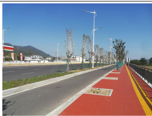
项目沿线现状照片
