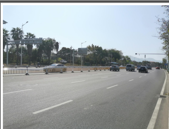
项目沿线现状照片
