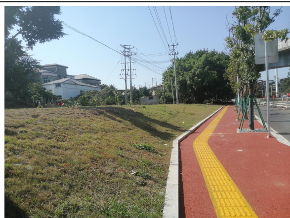
植草护坡现状照片
