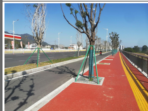
人行道彩色透水混凝土照片
