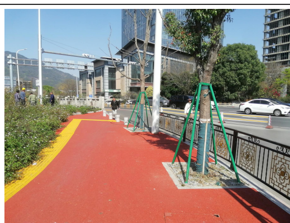
人行道彩色透水混凝土照片
