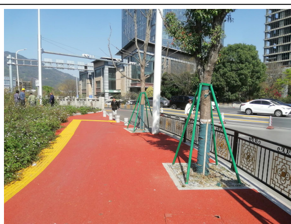
人行道彩色透水混凝土照片
