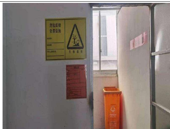
危险废物贮存间
