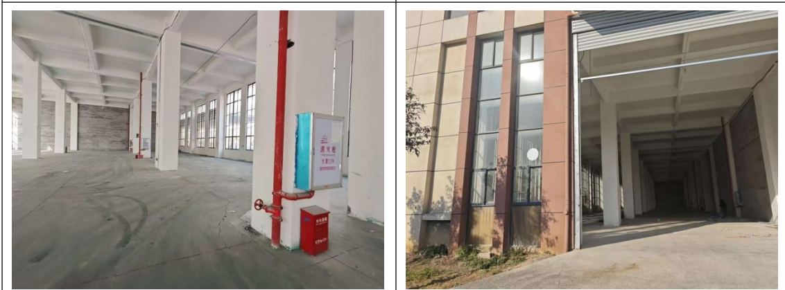
本项目厂房现状
