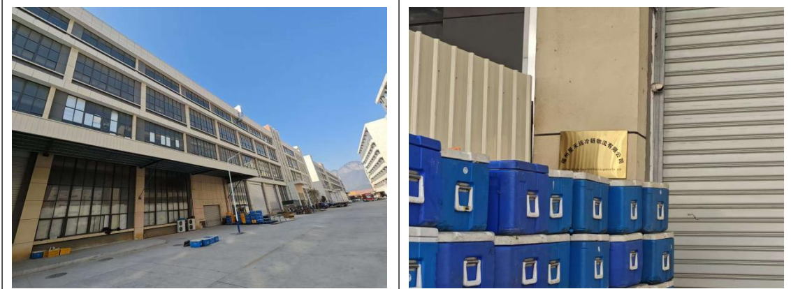
厂区北侧 4#厂房福州星禾远冷链物流有限公司
